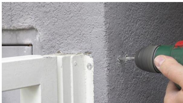
Marca y realiza los agujeros usando herramientas y una broca adecuada para su tipo de mampostería. En nuestro ejemplo utilizamos un taladrador de percusión con una broca de 6 mm.
