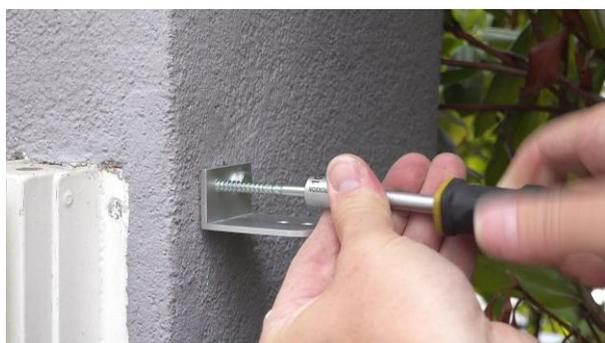
Después de haber instalado los tacos, hay que fijar la escuadra 1 con los tornillos. Asegúrate que los tornillos sean aproximadamente 10 mm más largos que los tacos utilizados.
